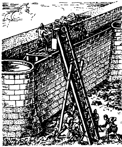
Рис. 2. Применение кошового элеватора с ручным приводом для строительства крепости
